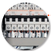
Interruttori magnetotermici per protezione delle linee di misura serie P1 MB [1A curva C, 10kA]
