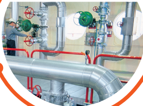
PUMPEN, BEWÄSSERUNG UND KANALISATION
